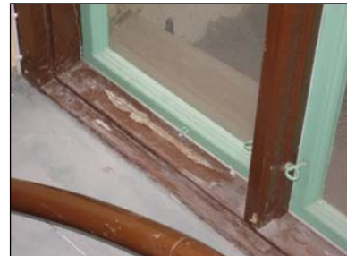
Fönsterkarm i gårdstrapphus
