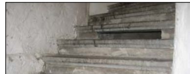
Källartrappa till tvättstuga, uppg 7C
