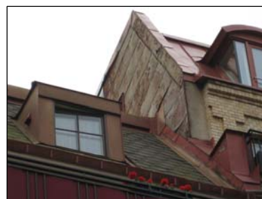
Plåtfasad mot öster
